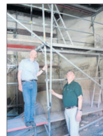
Noch ist die alte Wassermühle des Klosters Wöltingerode eine riesige Baustelle. Herwig Neufeldt (links), einer der für das Projekt verantwortlichen Naturschützer, und Administrator Günther Heuer-Brockmann planen gemeinsam die nächsten Schritte. Fotos (6) Herrmann
