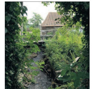
Noch macht die alte Wassermühle den Eindruck eines Domröschenschlosses. Ab 2011 werden Besucher hier über Lachse informiert.
